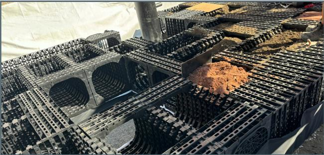
ENREGIS/TreeBoxen sorgen für Tragfähigkeit und die Versorgung mit Pflanzsubstrat und Wasser
