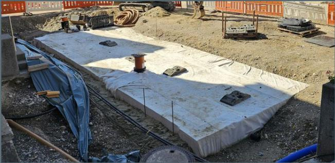
Baukörper der Baumstandorte bereits mit Vlies eingeschlagen, Öffnung für Wurzelballen folgt
